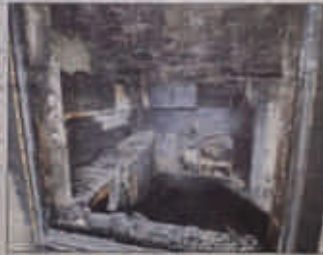
Die Wohnung des Opfers ist völlig zerstört. Spätestens nach Ansicht der Ermittler kam es zu einer Rauchgasvergiftung.
