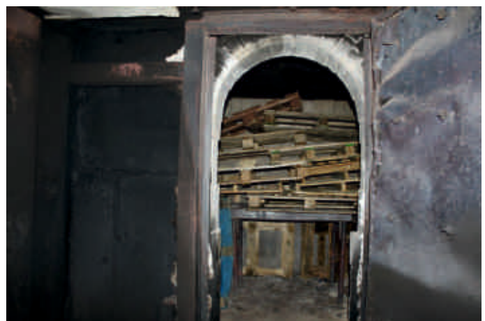
Der mit Paletten gefüllte Brandraum. Direkt davor befindet sich der Container mit den Teilnehmern.
