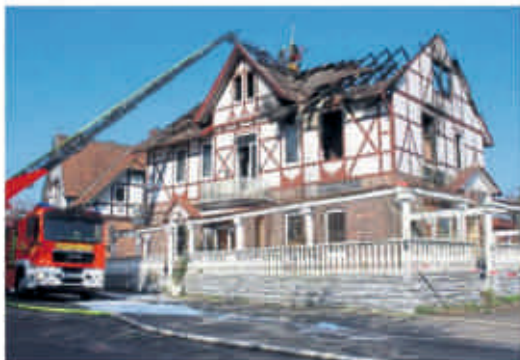
Die überdimensionale gewässerte Feuerwalze in der Sasendorfer Straße steht nach dem Brand vor der Ruine. 134 Feuerwehrleute haben zwei Stunden lang gearbeitet.
