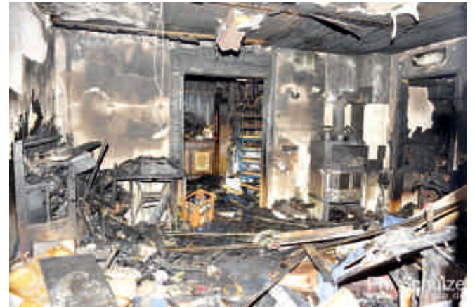
Das völlig zerstörte Erdgeschoss
