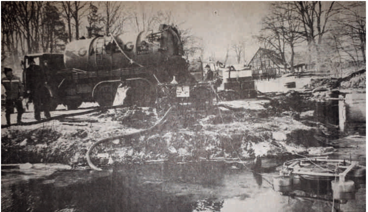
Die ankommenden Öllachen werden vor dem Medinger Wehr mit Skinnern abgesaugt
